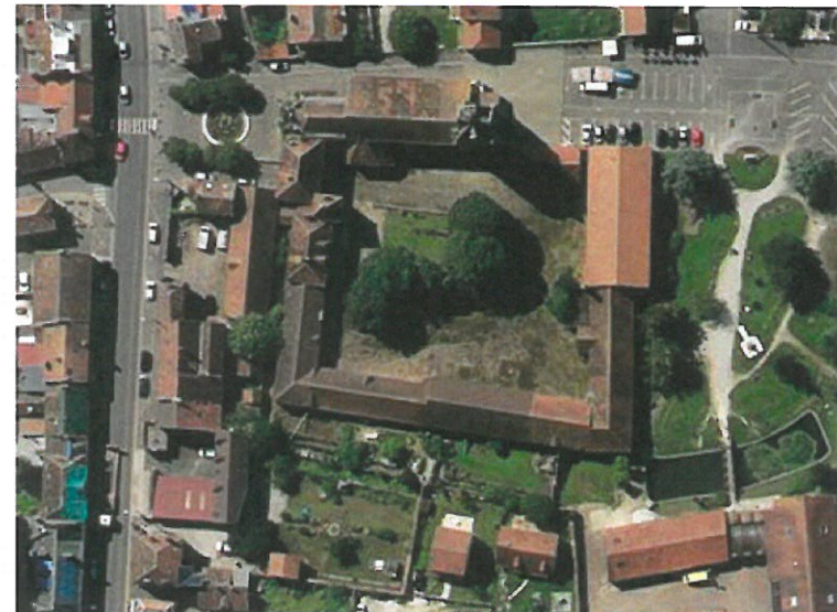
Vue aérienne de Mormant
